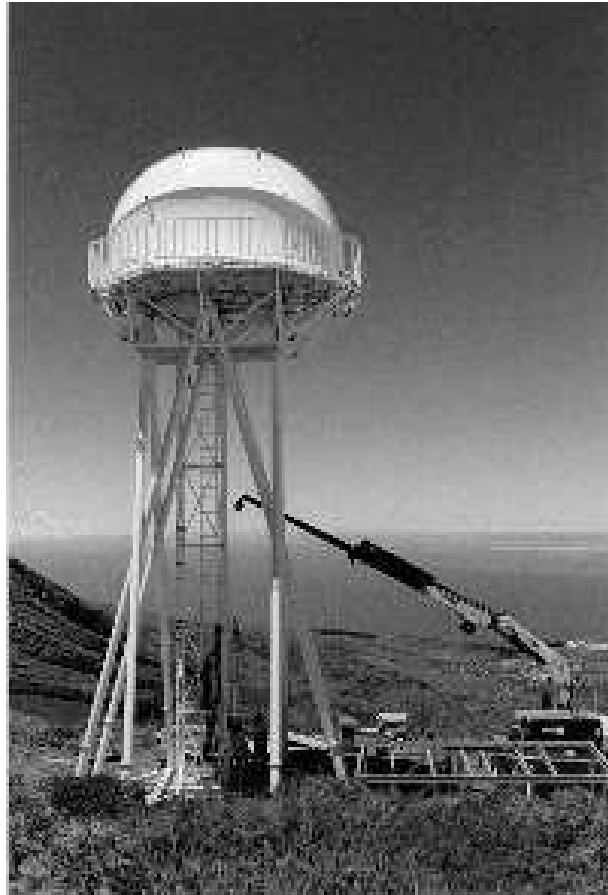
Figuur 3: De Dutch Open Telescope, gezien vanaf de Zweedse zonnetoren op de Roque de los Muchachos (La Palma). Je kijkt hier langs de DOT van 2300 meter neer op de zee. De foto is gemaakt op 28 juli nadat de telescoop en de wegklapbare koepel bovenop de vijftien meter hoge toren waren gehesen. Het frame waarin de telescoop werd vervoerd staat er nog naast. Telescoop, koepel en platform wegen zo'n dertig ton. Hammerschlag's ontwerp levert uitzonderlijke stijfheid. Dit is nodig omdat de seeing het best is bij flinke wind; juist dan moet de volgnauwkeurigheid binnen de 0.01 boogseconde blijven. De telescoop is gebouwd door de vakgroep Sterrekunde, de facultaire instrumentatiegroep (IGF) en de centrale werkplaats van de TU Delft met steun van de Stichting Technische Wetenschappen.
