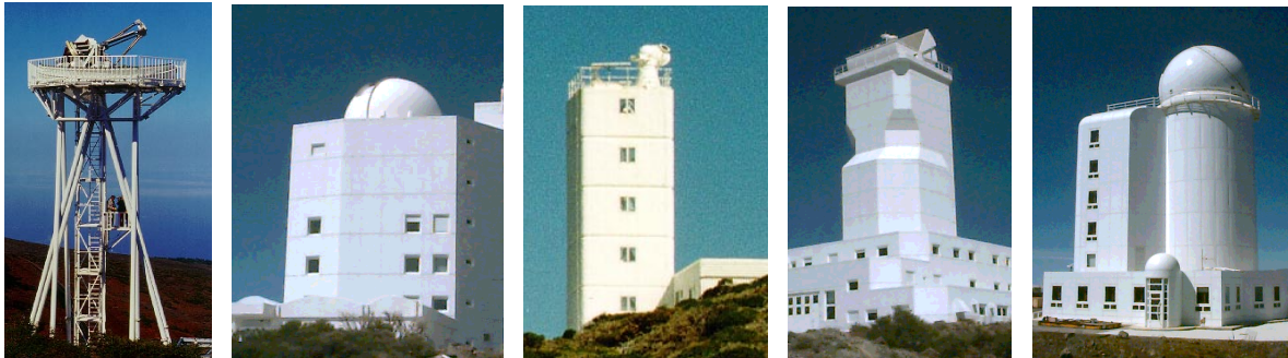
Figuur 4: Pasfoto's van Canarische zonnetelescopen in volgorde van apertuur. De gebouwgroottes corresponderen daar helemaal niet mee; in die maat zijn de GCT en VTT het grootst. Hun ontwerp dateert uit de tijd dat film als detector werd gebruikt; CCD's volstaan met kleinere beeldschaal. Er zijn op Tenerife nog een tiental andere zonnetelescoopjes voor specialistische doeleinden, vooral helioseismologie; dit zijn de algemeen inzetbare afbeelders. Ze zijn allemaal spierwit om lokale verhitting en turbulentie te vermijden. De DOT is duidelijk een buitenbeentje (ook in financieel opzicht: een koopje vergeleken bij de rest). Van links naar rechts: • DOT (Dutch Open Telescope), La Palma, apertuur 45 cm, gereed in 1997. Geschikt voor filtermagnetometrie met hoge oplossing. • GCT (Duitse Gregory Coud  Telescope), Tenerife, apertuur 45 cm. Vacuum reflector, vooral voor spectrografische magnetometrie. • SVST (Swedish Vacuum Solar Telescope), La Palma, apertuur 47 cm. Vacuum refractor met uitzonderlijk goede beeldscherpte. • VTT (Duitse Vacuum Tower Telescope), Tenerife, apertuur 70 cm. Algemene zonnetelescoop met uitgebreide postfocusapparatuur. • THEMIS (Frans-Italiaanse T lescope H liographique pour l'Etude du Magn tisme et des Instabilit s Solaires), Tenerife, apertuur 90 cm, gereed in 1997. Grote nieuwe-generatie telescoop speciaal voor spectrografische magnetometrie met hoge precisie.
