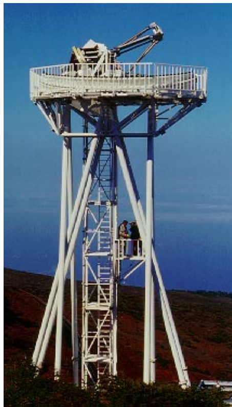
Figuur 1: De Dutch Open Telescope, La Palma, september 1996. De telescoop is hier op de poolster gericht. Hij staat op een 15 m hoog platform nabij de 2400 m hoge Roque de Los Muchachos, temidden van een groeiend aantal telescopen waaronder drie UK/NL telescopen voor nachtsterrenkunde. De ontwerper, Rob Hammerschlag, staat halverwege in de lift. De slecht-weer koepeltent is weggekapt. De open structuur van telescoop en toren dienen om de passaatwind die de beste seeing op La Palma brengt minimaal te verstoren. Omdat de beste seeing komt bij harde wind (5–10 m/s, Bf 4–6) heeft Hammerschlag allerlei uitvindingen moeten doen om te zorgen dat de telescoop wel beweegbaar is maar niet in de wind wiebelt. Die nieuwe technologie vormt de reden waarom de Stichting Technische Wetenschappen de bouw en installatie van de DOT financiert. Uitvoerders zijn het Sterrekundig Instituut, de facultaire instrumentatiegroep (IGF) en de centrale werkplaats van de TU Delft. Deze zomer moeten de eerste beelden komen. Foto van Ed van der Zalm.
